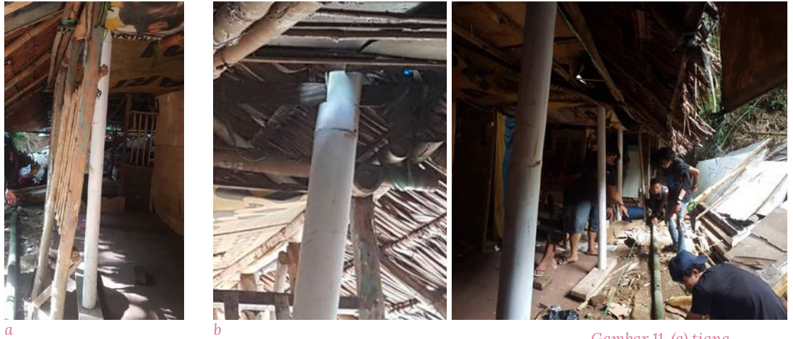
Gambar 11. (a) tiang penopang berwarna putih, tiang eksisting adalah bambu yang miring, (b) tiang eksisting sudah dicabut, tersisa tiang penopang (Dokumentasi penelitian, Juli 2019)
